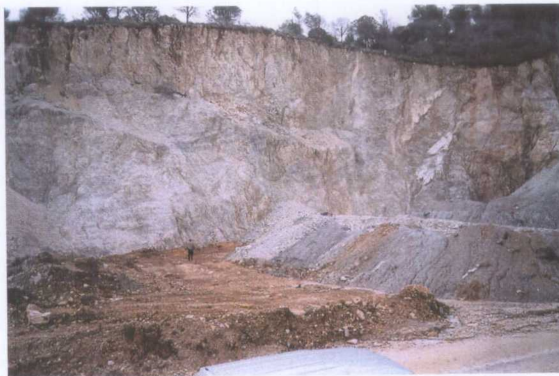
Relleno parcial de la parte Norte.
