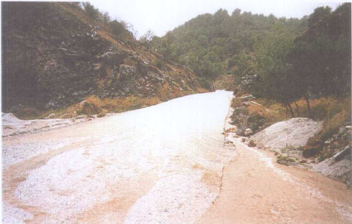
Fotografía 14. Materiales arrastrados por el arroyo Blanquillo y sedimentados en la pista que le sirve de cauce. (Septiembre de 1999).
