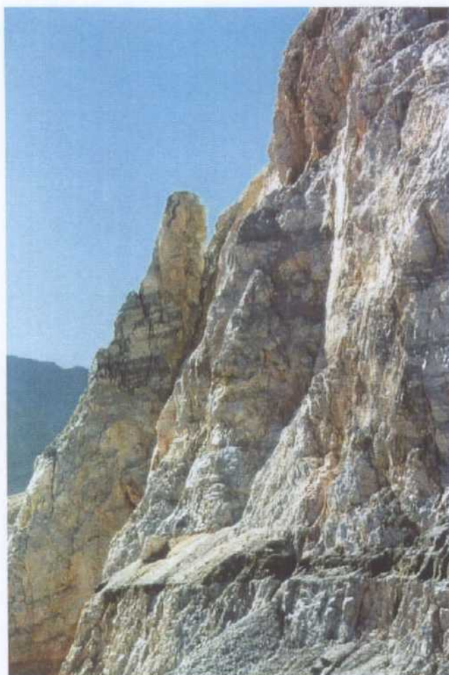
Fotografía 2. Talud de la zona Norte de Aripisa.
