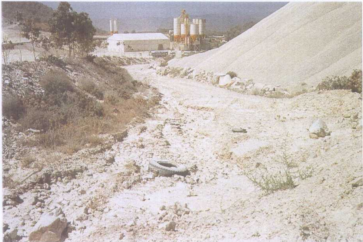
Fotografía 12. Estado actual del cauce del arroyo del Pinar entre Taralpe y El Pinar I.
